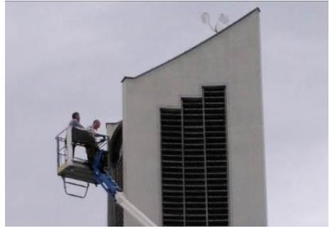
nigt und alle Dachkanten mit einem elektrischen Abwehrsystem versehen, welches von einem Solarpanel auf dem Turmdach mit Spannung versorgt wird. Über den Schallbrettern der Glockenstube wurden von außen Netze angebracht. Die Baumaßnahme mit über 10.000 Euro Kosten war erfolgreich.
